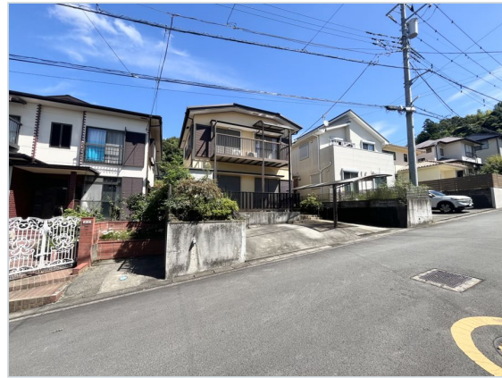
現地外観（斜めより）
