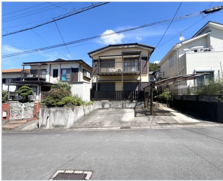
① 現地全景（前面道路より）
